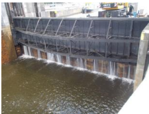
Pohled na horní vrata VPK a strojovnu zdvihadel horních vrat VPK
