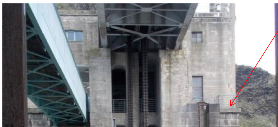
Rozsah opravy pilíře dle SO04 (pravý pilíř)
